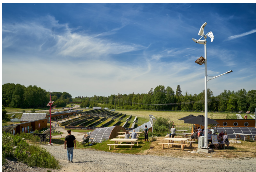
ETC Solpark norr om stationen i Katrineholm har en kapacitet på över 4 000 000 W, och som ska växa mer under 2021 tack vare de som klimatkompenserar och sparar i våra solceller.
